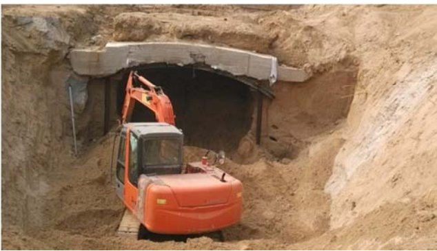
图9 在预衬砌结构保护下模拟隧道开挖。
