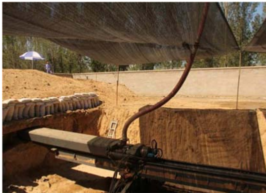
图2 现场切槽及灌注混凝土过程。
