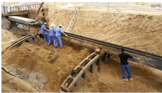
图3 槽段插入钢筋试验。
