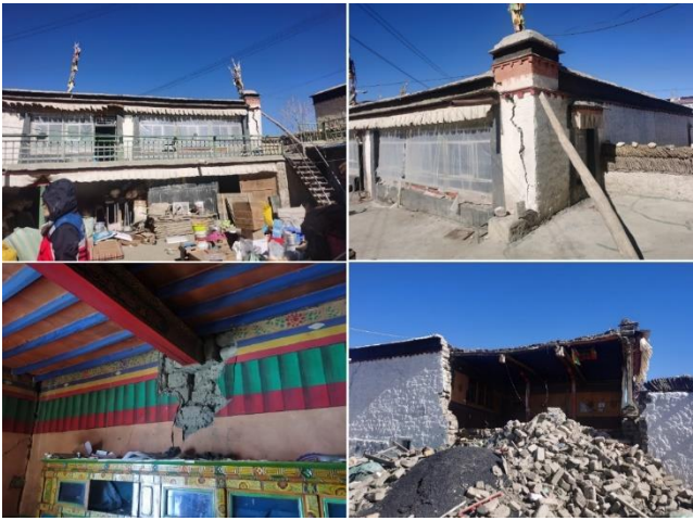
图8 拉孜县老旧民房破坏（拉孜县曲下镇隆东江热村，评定烈度VII度）。
