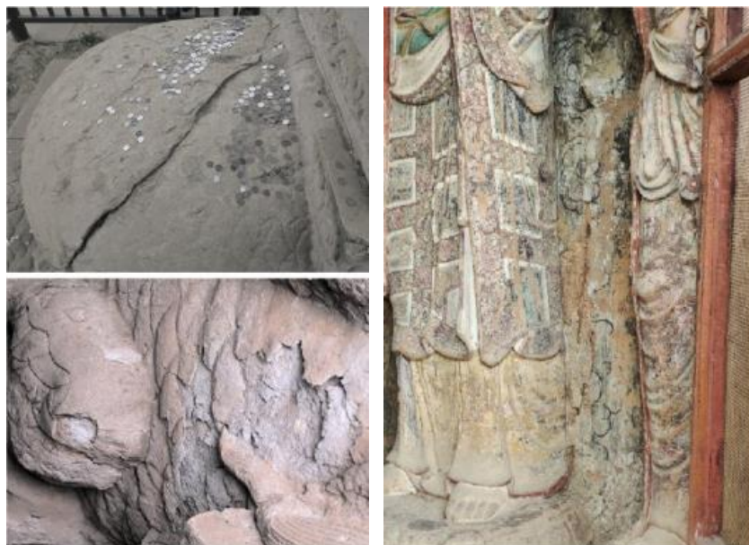
(a) 承德永佑寺石碑热病害 [22] (b) 麦积山石窟太阳辐射劣化 [23]
