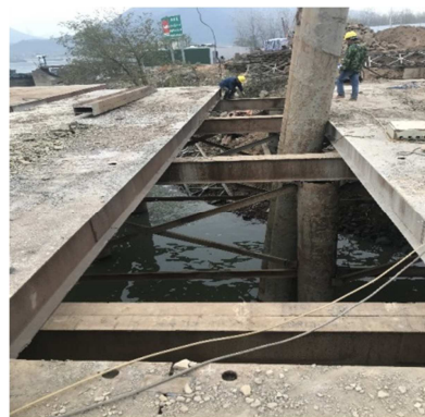
图12 搭建钢栈桥。
