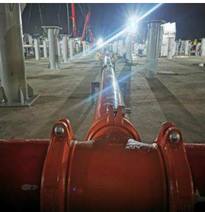
图15 优化后的镀锌钢管现场安装实图。
